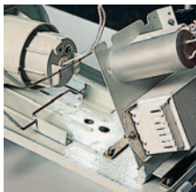
Замена блока ПРА
